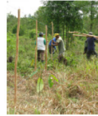
Pemasangan tiang persemaian KMPH Bina Desa
