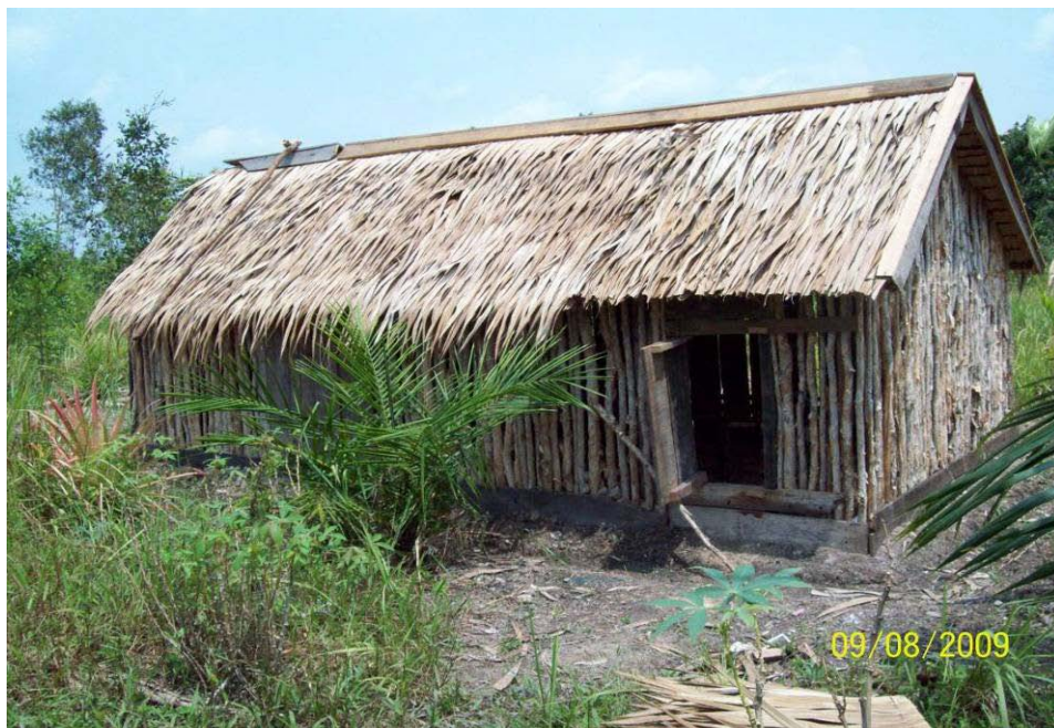
Gambar 7. Kandang ayam buras sederhana dibuat dari kayu gelam, atap rumbia dan lantai kandang tanah yang dipadatkan diberi alas serbuk gergaji.
