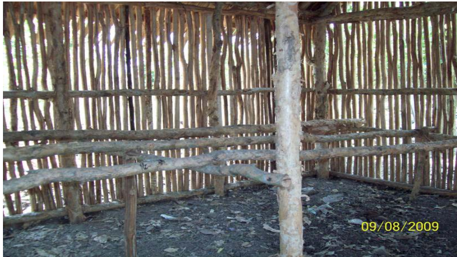
Gambar 12. Tempat bertengger dari kayu gelam.
