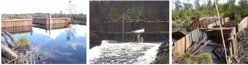
Gambar 53 : 1 dan 2. Konstruksi Tabat di Saluran ex PT SSI Setelah Selesai Dibangun (Dokumentasi: WWF-Indonesia/Drasospolino, 2004), 3. Tabat yang dibangun di hilir (kiri) eks saluran PT SSI rusak terhantam arus air yang kuat pada bulan Januari 2005 (Dok WWF-Indonesia/Adventus Panda, 2005) ( Sumber : Panduan Penyekatan Parit dan Saluran di Lahan Gambut Bersama Masyarakat, WI-IP. 2005)
