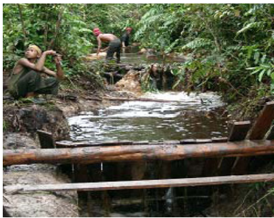
Gambar 42. Sistem buka - pasang tabat/sekat sementara di parit-parit sekitar Sungai Merang (Foto. Suryadiputra, Juni 2004) (Sumber: Panduan Penyekatan Parit dan Saluran di Lahan Gambut Bersama Masyarakat, WI-IP. 2005)
