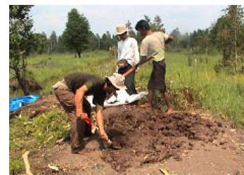
Gambar 48. Penimbunan tanah di dalam tabat (Sumber: Panduan Penyekatan Parit dan Saluran di Lahan Gambut Bersama Masyarakat, WI-IP. 2005)
