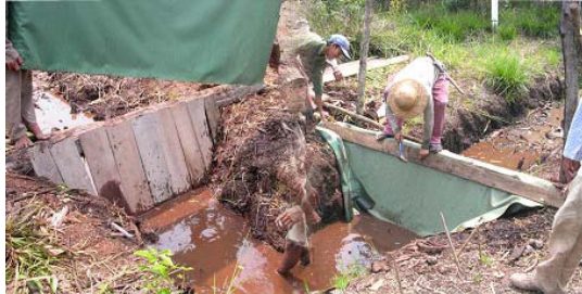
Gambar 40. Pemasangan plastik atau terpal pada dinding sekat (Foto: Alue Dohong) (Sumber: Panduan Penyekatan Parit dan Saluran di Lahan Gambut Bersama Masyarakat, WI-IP. 2005)
