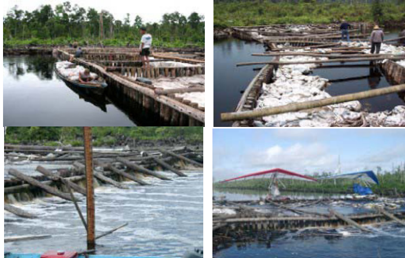
Gambar 33 : 1. Tabat 1 dalam proses penyelesaian (Juni 2004), 2. Tabat 1 melengkung akibat tekanan arus air yang sangat kuat (Oktober 2004), 3. Tabat 1 setelah diperbaiki (Des 2004) dan 4. Tabat 1 setelah diperbaiki menjadi tempat parkir pesawat ringan (Des 2004) (Sumber: Panduan Penyekatan Parit dan Saluran di Lahan Gambut Bersama Masyarakat, WI-IP. 2005)
