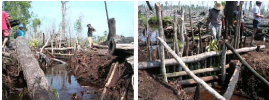
Gambar 41. Kegiatan konstruksi sekat (Foto: I N.N. Suryadiputra) (Sumber: Panduan Penyekatan Parit dan Saluran di Lahan Gambut Bersama Masyarakat, WI-IP. 2005)
