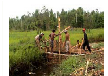
Gambar 47. Pemasangan penyangga tegak (Sumber: Panduan Penyekatan Parit dan Saluran di Lahan Gambut Bersama Masyarakat, WI-IP. 2005)
