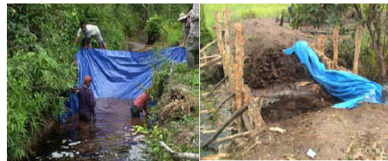
Gambar 43. Tahapan pembangunan tabat sementara oleh Proyek CCFPI di lokasi parit milik pak Nasir (koordinat : S 01057'34.0" , E 103059'08.7"), tabat ini akhirnya dibongkar penebang liar yang identitasnya tidak diketahui (Foto: I N.N. Suryadiputra) (Sumber: Panduan Penyekatan Parit dan Saluran di Lahan Gambut Bersama Masyarakat, WI-IP. 2005)
