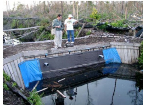
Gambar 25. Sekat isi yang dibangun oleh Yayasan BOSF-MAWAS disalah satu saluran eks-PLG Daerah Tuanan, Kalimantan Tengah ( Sumber: Panduan Penyekatan Parit dan Saluran di Lahan Gambut Bersama Masyarakat, WI-IP. 2005)
