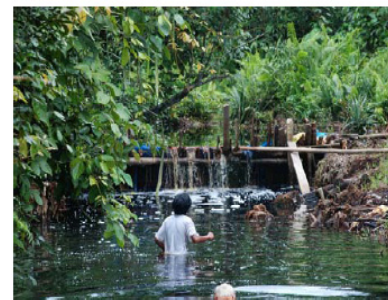
Gambar 17 : Kanal yang ditutup/disekat di Sungai Buring (Foto: LSM Satu Hijau, 2009)
