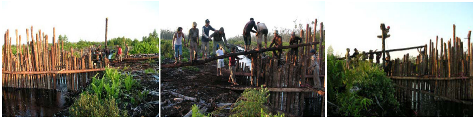
Gambar 35. Para pekerja sedang memasang menara/tonggak kayu dan mengangkat tiang belangiran pengikat (Foto: I N.N. Suryadiputra 2004) (Sumber: Panduan Penyekatan Parit dan Saluran di Lahan Gambut Bersama Masyarakat, WI-IP. 2005)
