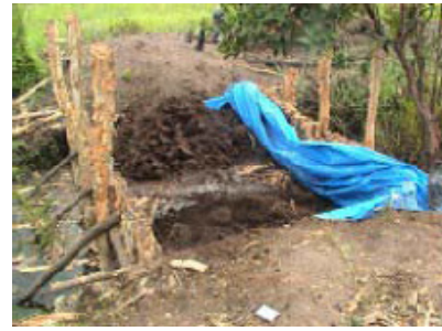
Gambar 46. Pemasangan cerucup di dalam saluran yang ditabat (Sumber: Panduan Penyekatan Parit dan Saluran di Lahan Gambut Bersama Masyarakat, WI-IP. 2005)
