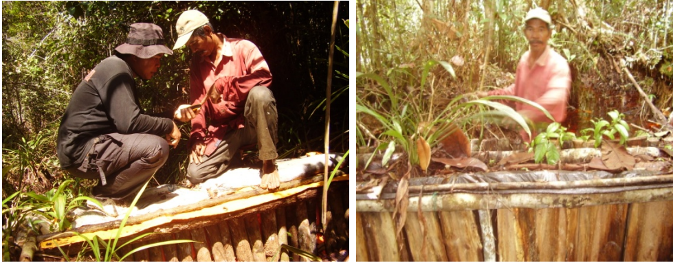
Gambar 59. Kontruksi sekat BOSF-Mawas dan pemeliharaan sekat oleh Kelompok RPK di Desa Batampang Kecamatan Dusun Hillir Kabupaten Barito Selatan (Dok. BOSF-Mawas, 2006)
