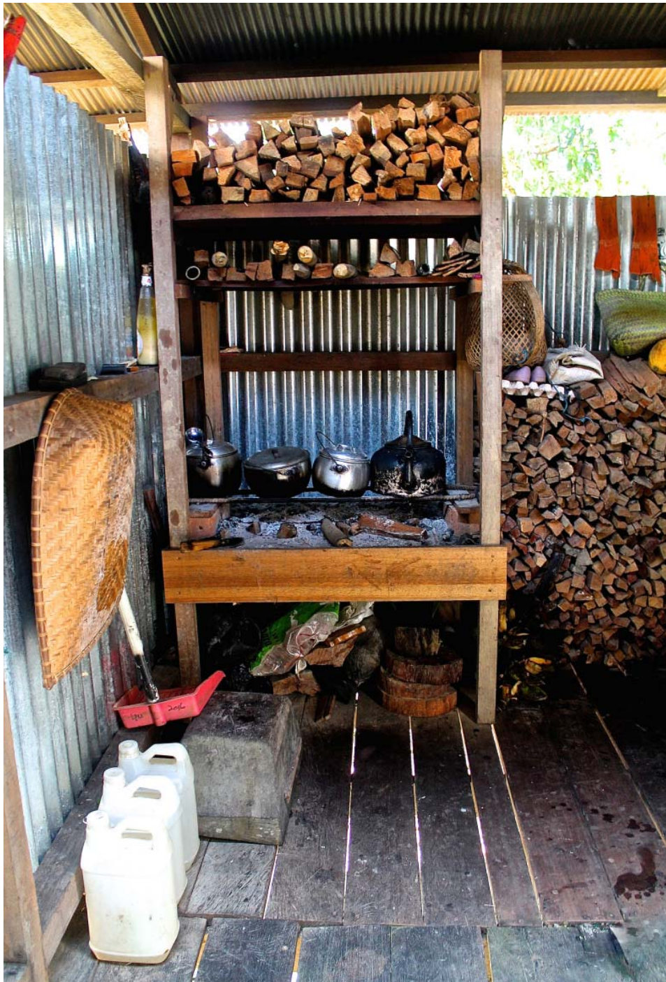
Gambar 17. Tungku kayu di rumah panggung kayu, rentan menyebabkan kebakaran di Desa Setulang.
